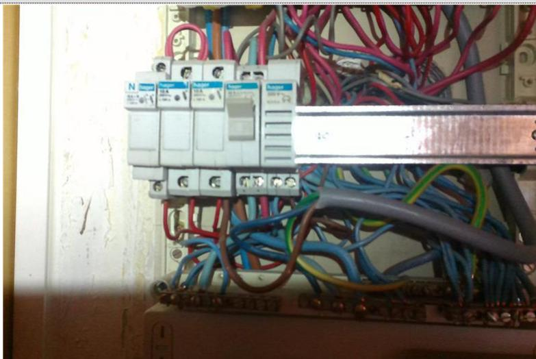
Description : Le courant assigné (calibre) de la protection contre les surcharges et courts-circuits d'au moins un CIRCUIT n'est pas adapté à la section des CONDUCTEURS correspondants.
