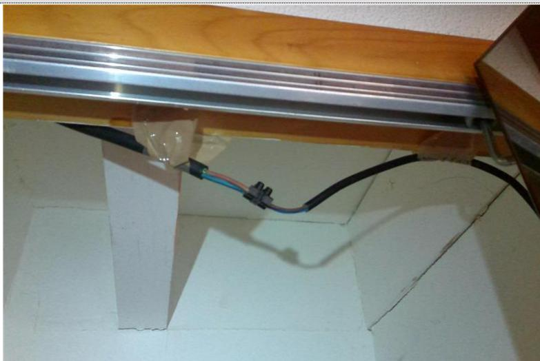
Description : L'installation électrique comporte au moins une CONNEXION avec une partie active nue sous tension accessible.
