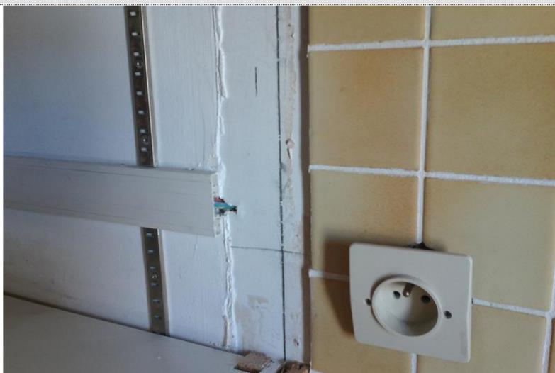
Description : Au moins un CONDUCTEUR isolé n'est pas placé sur toute sa longueur dans un conduit, une goulotte, une plinthe ou une huisserie, en matière isolante ou métallique, jusqu'à sa pénétration dans le MATERIEL ELECTRIQUE qu'il alimente.
