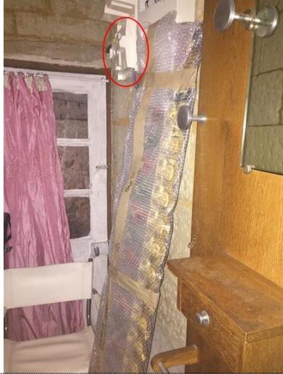
**Description :** Le dispositif assurant la COUPURE D'URGENCE est placé à plus de 1,80 m du sol fini et n'est pas accessible au moyen de marches ou d'une estrade.
