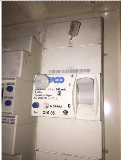
**Description :** Au moins un dispositif de protection différentielle ne fonctionne pas pour son seuil de déclenchement.
