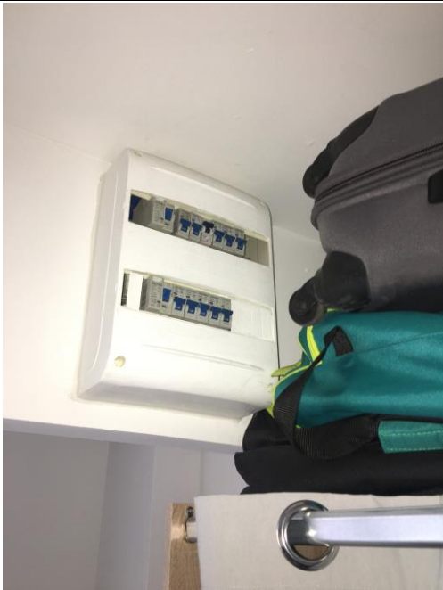
Photo du tableau électrique
