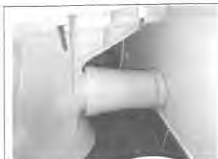
Photo n° PhA004 Localisation : Salle de bain Ouvrage : 3. Conduits, canalisations et équipements intérieurs - Conduits de fluides (air, eau, autres fluides) Partie d'ouvrage : Conduits Description : Conduit PVC Localisation sur croquis : M004
