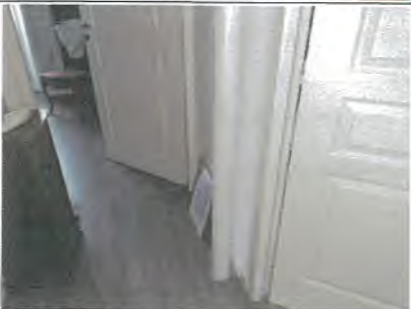
Photo n° PhA003 Localisation : Dégagement Ouvrage : 3. Conduits, canalisations et équipements intérieurs - Conduits de fluides (air, eau, autres fluides) Partie d'ouvrage : Conduits Description : Conduit Localisation sur croquis : M003
