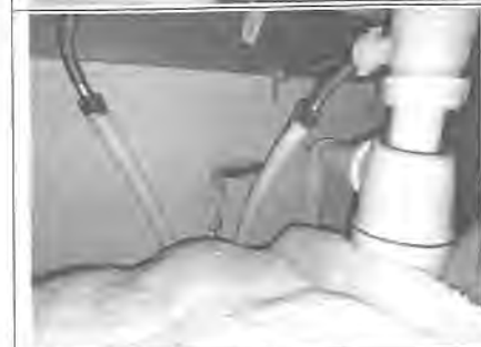
Photo n° PhA006 Localisation : Salle d'eau Ouvrage : 3. Conduits, canalisations et équipements intérieurs - Conduits de fluides (air, eau, autres fluides) Partie d'ouvrage : Conduits Description : Conduit PVC Localisation sur croquis : M006
