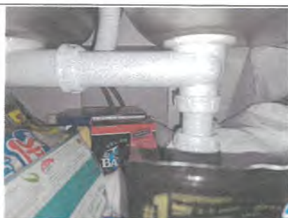
Photo n° PhA001 Localisation : Cuisine Ouvrage : 3. Conduits, canalisations et équipements intérieurs - Conduits de fluides (air, eau, autres fluides) Partie d'ouvrage : Conduits Description : Conduit PVC Localisation sur croquis : M001
