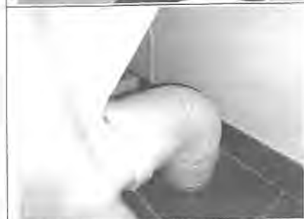
Photo n° PhA005 Localisation : Wc Ouvrage : 3. Conduits, canalisations et équipements intérieurs - Conduits de fluides (air, eau, autres fluides) Partie d'ouvrage : Conduits Description : Conduit PVC Localisation sur croquis : M005
